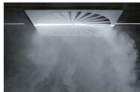
Configurazione in riscaldamento (aria >22°C)
